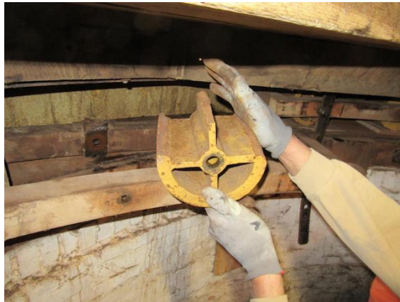
Het uitbouwen van de gebroken kruirol
