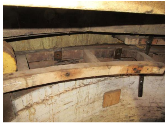
Het uitbouwen van de gebroken kruirol
