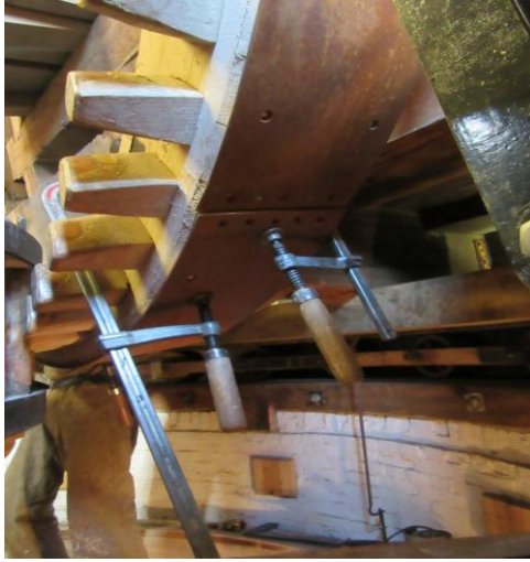
Het aanbrengen van de stalen voering op het bovenwiel
